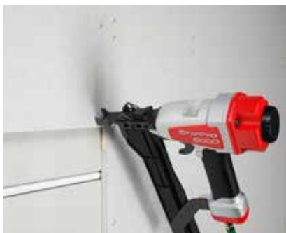
Pričvrščivanje dodatnog sloja fermacell® gips vlaknastih ploča ili Powerpanel H 2 O uključujući izradu fuga
