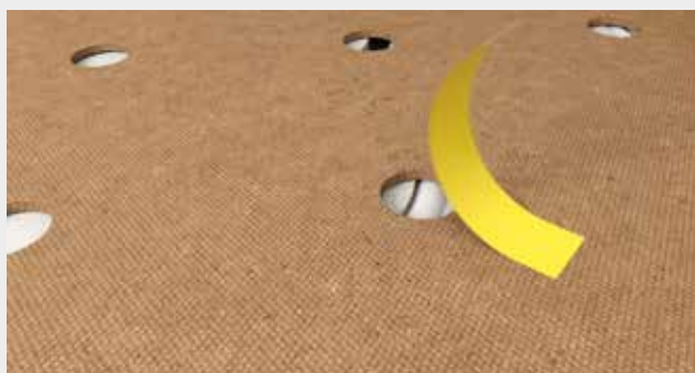
Postavite šablonu na planirano područje fermacell® gips-vlaknaste ploče kao pokrovnu ploču. Provjerite ima li u području pričvršćivanja cijevi za grijanje. Ako je tako, prekrijte točku pričvršćivanja trakom.
