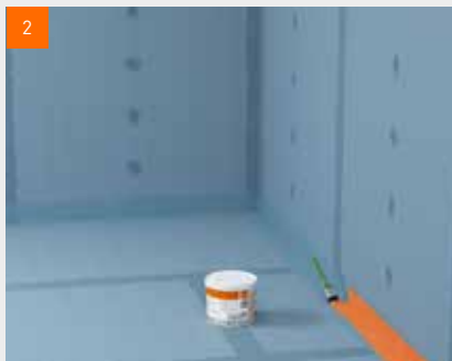
2 Nanesite fermacell™ tekuću foliju u kut
