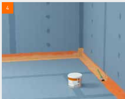
4 Brtvena traka odmah nakon utiskivanja. Oboite fermacell™ tekuću foliju.
