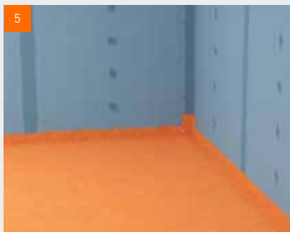
5 Puno površinsko brtvljenje podržaja u području W1-1.
