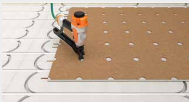
Montaža pokrovne ploče i mehaničko pričvršćivanje vijcima ili spajalicama pomoću šablone.
