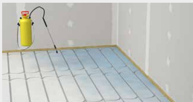
Temeljite fermacell® Therm25 elementi dubinskim temeljnim premazom ferma-
