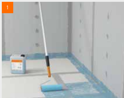
1 Valjkom nanesite fermacell™ sredstvo za imregnaciju na susjedni zid i pod.
