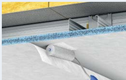
Nadoknaditi nedostatak boje KEIM Soldalit prouzročen odstranjenjem rubne izolacije.
