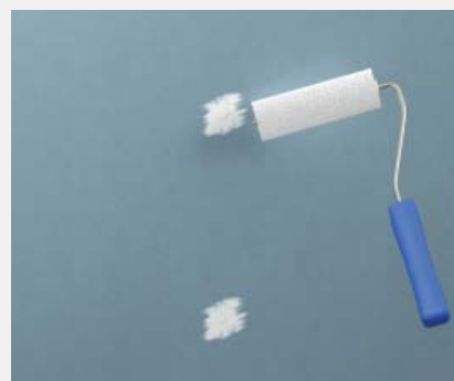
Pokrivanje sredstva za pričvršćivanje s fermacell™ armaturnim ljepilom HD
