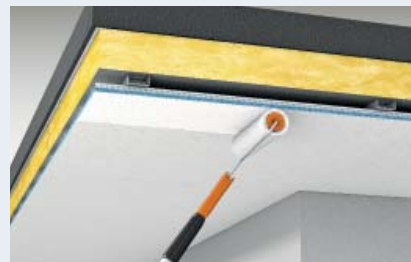
Nastavno se cijela površina oblaže - mokro u mokro - KEIM Soldalitom. Cjelokupna potrošnja boje KEIM Soldalit za polaganje fermacell Powerpanel flisa iznosi oko 0,7-0,9 kg/m 2 .
