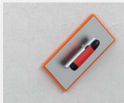
Filcanje površine žbuke sa spužvastim alatom
