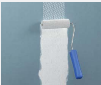
Premazivanje armaturne trake s fermacell™ armaturnim ljepilom HD
