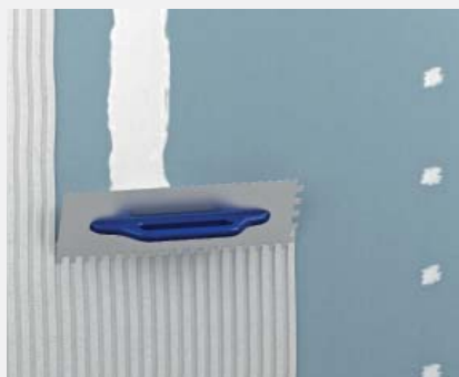
Nanošenje fermacell™ laganog morta HD s 5-6 mm debljine sloja za temeljnu žbuku
