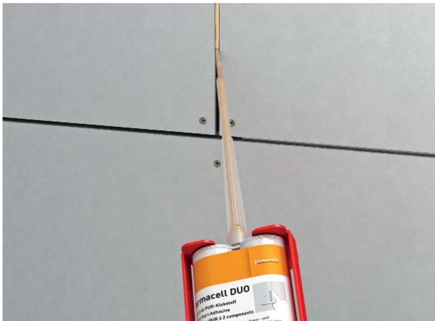
Naknadno lijepljenje s fermacell™ DUO ljepilom
