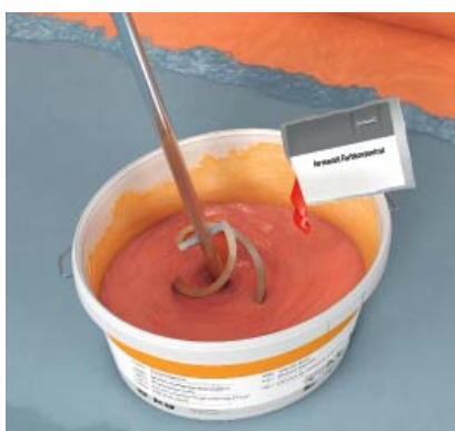
Prikaz 8: 2. nanošenje: dodati koncentrat boje ostatku količine tekuće folije i homogeno izmiješati. Obojenu tekuću foliju dostatno nanijeti. Daljnje informacije možete pronaći u tehničkom listu proizvoda. Preporuča se poprečno nanošenje drugog nanosa na prvi, kako biste izbjegli eventualne nepravilnosti u sloju brtvila.
