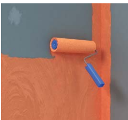
Prikaz 7: fermacell™ tekuću foliju nanijeti valjkom 2 x preko cijele površine (ukupna debljina sloja najmanje 0,5 mm). Prema DIN 18534-3 kod 2. nanošenja zahtjev na razliku boje za bolju sljedivost.
