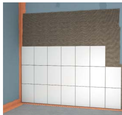
Prikaz 6: Polaganja pločica s fermacell™ Flex ljeplom, u radu s tankoslojnom žbukom (osiguranje brtvljenja za klasu djelovanja vode W1-I)
