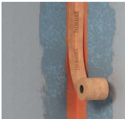
Prikaz 2+3: fermacell™ brtveću traku u ranije nanesej još vlažnoj fermacell™ tekućoj foliji pritisnuti i izravno s tekućom folijom premazati. Vrijeme sušenja najmanje 1 sat
