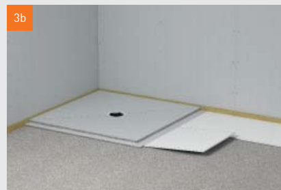
Varijanta B: Kako bi došli do visine preklopnog falca elementa za tuš, polaže se izolacijski materijal (EPS-DEO 150) debljine 10 mm preko površine.
