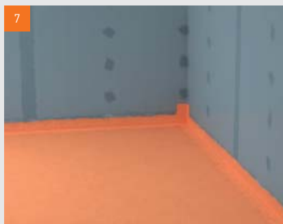
U vlažnu tekuću foliju utisnuti fermacell™ brtvenu traku
