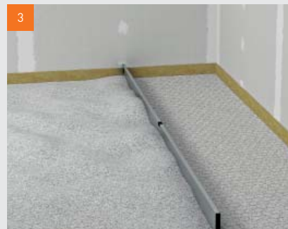
Postavljanje fermacell™ nasipa za saće
