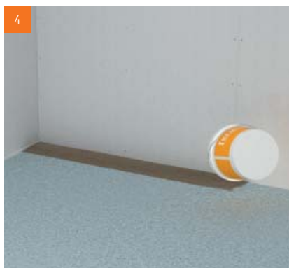
Tada vezno sredstvo T ima konzistenciju vlažne zemlje. Prvi sloj izolacije se polaže.
