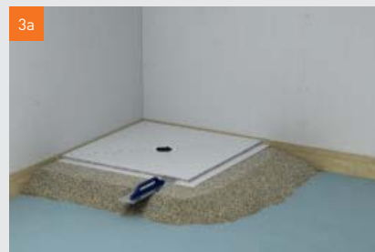
Varijanta A: Okolno elementu za tuš nasipa se izolacija u visini preostalog falca u visini oko 200 mm kao podloga za ostatak površine
