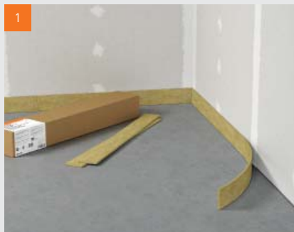
Izvedba rubne izolacijske trake
