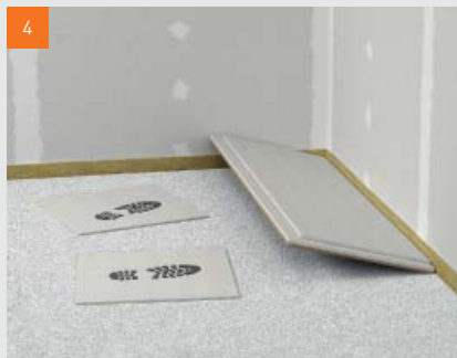
Postavljanje fermacell® estrih elemenata na fermacell™ nasip za izravnavanje
