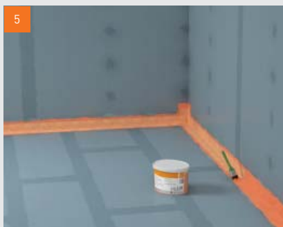
Brtvenu traku odmah nakon utiskivanja premazati fermacell™ tekućom folijom - vrijeme sušenja - najmanje 1 sat
