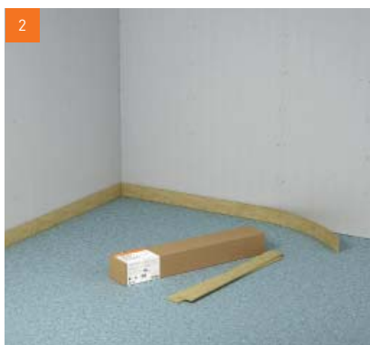
Nastavno slijedi nanošenje rubne izolacijske trake prema potrebi
