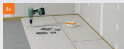
3 Polaganje fermacell® estrih elementa
