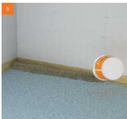
Vezno sredstvo tad ima konzistenciju - vlažne zemlje. Prva izolacija se polaže.
