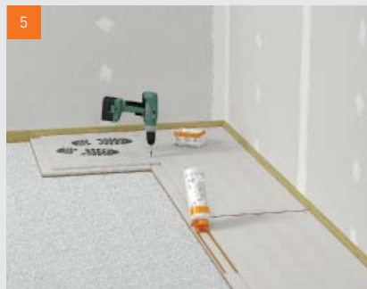
Postavljanje fermacell® estrih elemenata na fermacell™ nasip za izravnavanje
