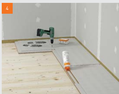
4 Nanošenje fermacell™ estrih ljepila u području filca
