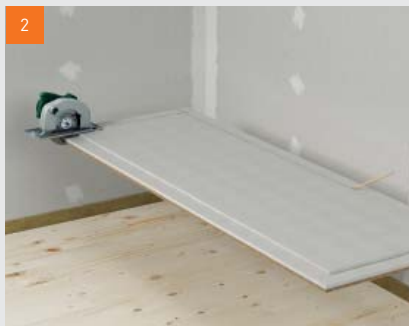
2 Otpiliti stršeci preklap filca za prvi sloj polaganja
