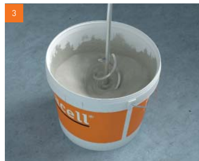
Pomoću prikladne mješalice malih okretaja miješati do nastanka homogene nivelir mase bez grudica.
