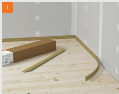
1 Položiti rubne izolacijske trake a u kutevima tupo spojiti
