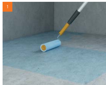
Priprema: grundirati pod
