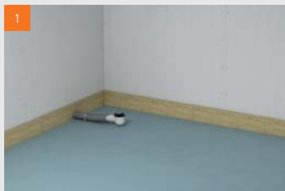
Nakon označavanja mjesta elementa za tuš, smješta se kućište za odvod
