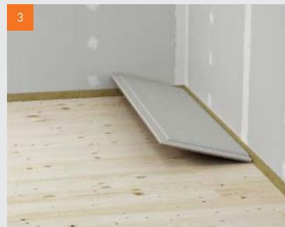
3 Polaganje fermacell® estrih elementa
