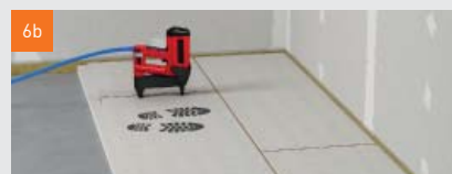
6a Pričvršćivanje vijcima ili posebnim razupornim klamicama unutar 10 min.
