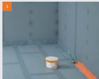
fermacell™ tekuću foliju nanijeti u kut
