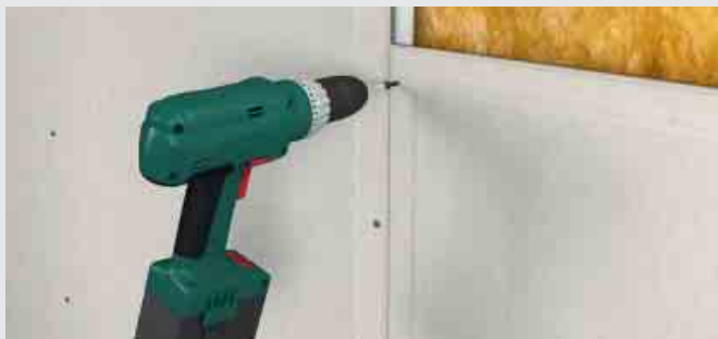
Vijci na čeličnu potkonstrukciju
