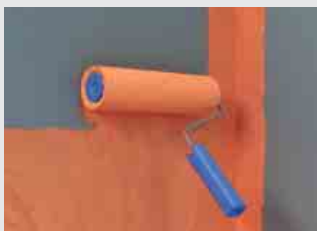
Prikaz 6: Osiguravanje brtvljenja za klasu W1-I i W2-I potrebno je fermacell™ tekuću foliju nanijeti valjkom min. 2 x preko cijele površine (debljina suhog sloja min 0,5 mm). Prema DIN 18534-3 zahtjeva se 2. nanošenje zbog bolje transparentnosti. 1. nanos: fermacell™ tekuću foliju nanijeti dostatno u originalnoj boji i ostaviti da se suši.
