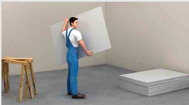
Pojedinačne fermacell® gipsvlaknaste ploče nositi vertikalno
