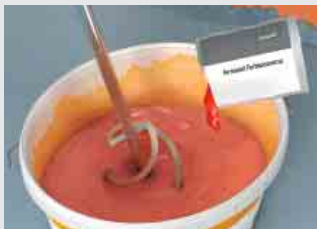
Prikaz 7: 2. nanos: dodati ostatku tekuće folije koncentrat boje i homogeno izmiješati. Obojenu tekuću foliju nanijeti u dostatnoj količini. Daljnje informacije možete pronaći u podacima o proizvodu. Preporuča se poprečno nanošenje drugog premaza u odnosu na prvi kako bi se spriječile eventualne nepravilnosti u sloju brtvljenja.
