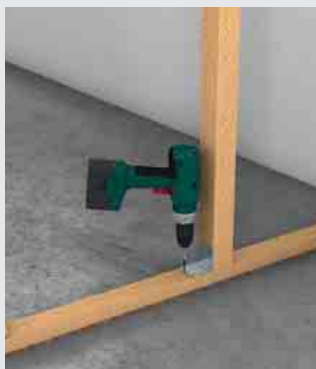
Montaža drvenih profila s čavlima i čeličnim kutnicima
