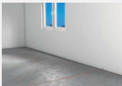
Polaganje zidne osovine s vrpcom ili laserom za visoku gradnju
