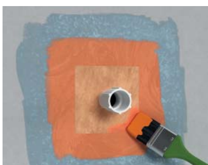
Slika 4+5: Za brtvljenje odvodnica, treba polegnuti fermacell™ zidnu manšetu u još vlažnu tekuću fermacell™ foliju i direktno ponovno premazati. Vrijeme sušenja: 1 sat
