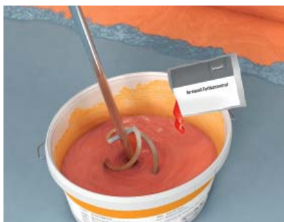
Slika 8: 2. Nanos: Koncentrat boje dodati ostatku tekuće folije i homogeno promiješati. Obojenu tekuću foliju dostatno nanijeti. Daljnje informacije možete pronaći u listu s podacima proizvođača. Preporuča se drugi premaz nanijeti poprečno prema prvom, kako bi se izbjegle nepravilnosti u sloju brtvljenja.
