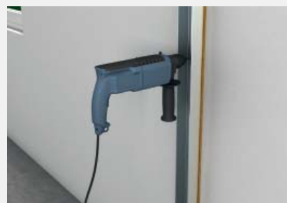
Pričvršćenje CW profila na masivni zid i izolacijsku traku
