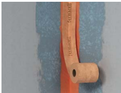
Slika 2+3: fermacell™ brtvena traka pritisnuta u prethodno nanosenu, još vlažnu, tekuću foliju i izravno premazati s tekućom folijom - vrijeme sušenja min 1 sat.
