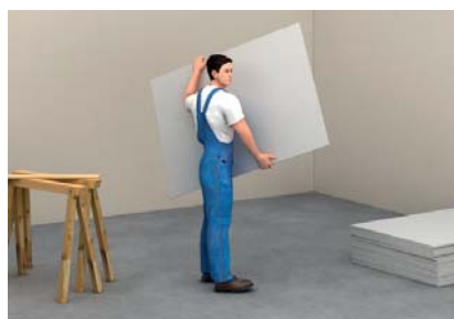
Pojedinačne fermacell® gipsvlaknaste ploče nositi uspravno
