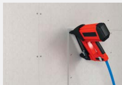
Klamice fermacell® gipsvlaknaste ploče na fermacell® gipsvlaknaste ploče (neutralno na potkonstrukciju)
