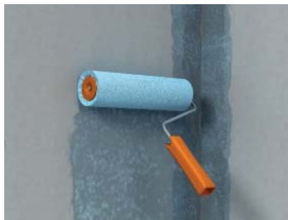
Slika 1: Nanošenje fermacell™ Tiefengrunda preko cijele površine - vrijeme sušenja min 2 sata - Odnos miješanja: 1:1 do 1:2 s vodom
