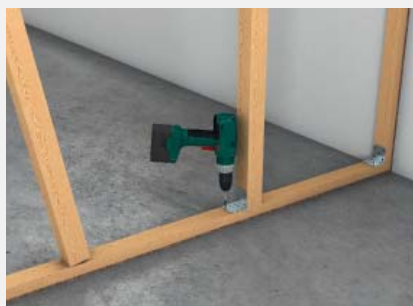
Montaža drvenih profila s klinastim čavlima ili čeličnim kutnicima.
