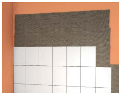
Slika 9.: Postavljanje keramičkih pločica s fermacell™ flex ljepljivom u postupku tankog sloja na brtvljenje preko cijele površine
